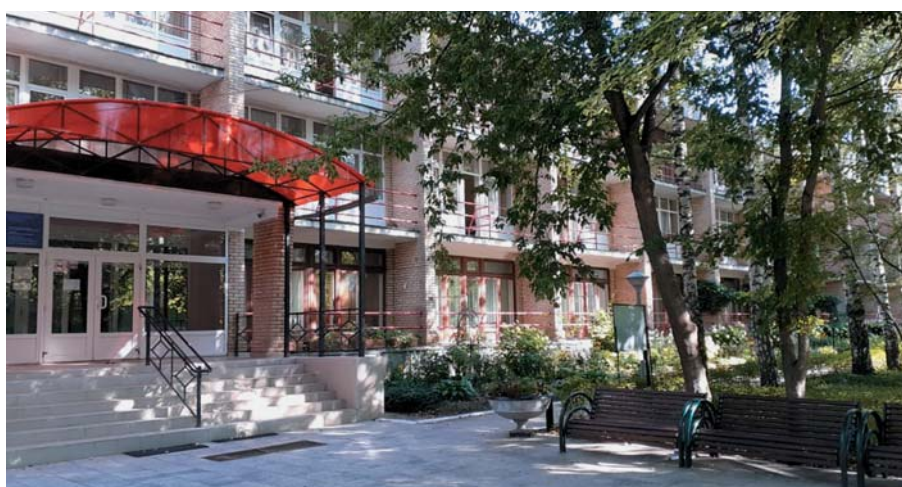
Рис. 3. Вид корпуса, где пациенты проходят раннюю реабилитацию после хирургических и эндоваскулярных операций на сердце и сосудах (пос Быково, Моск обл., ул. Опаринская, 11).
